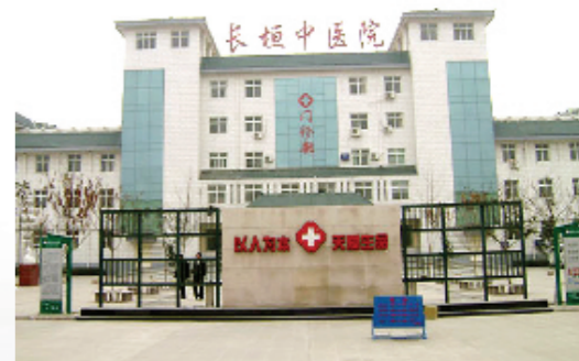
长垣县中医院门诊楼
